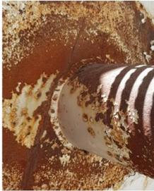
En varias tuberías y pared del ducto del escape se encontraron grietas como se observa en la foto, las cuales requieren reparación para evitar fuga de gases.
